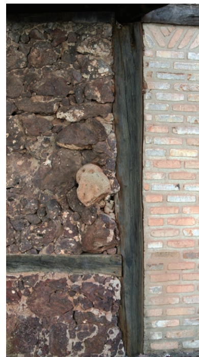
Construção feita em blocos de recife, Cumuruxatiba, BA.
